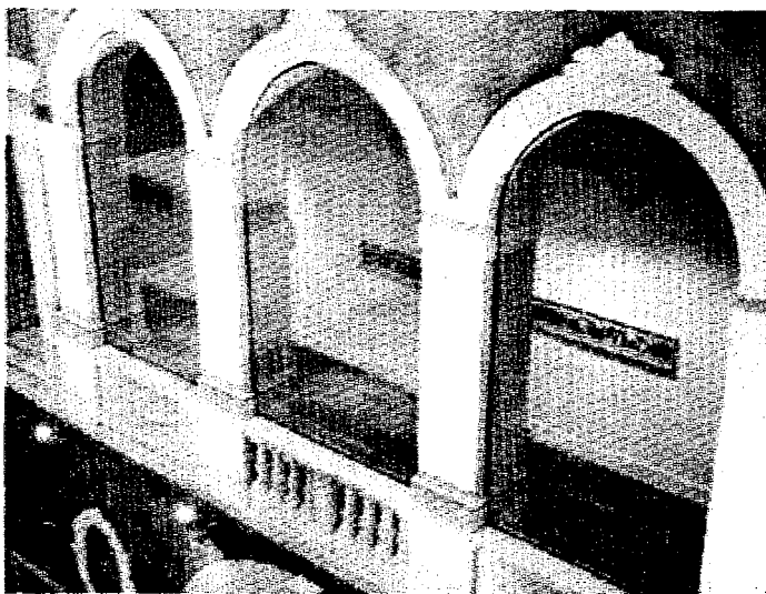
Le arcate del primo piano che si affacciano sulla corte di Palazzo Valle
